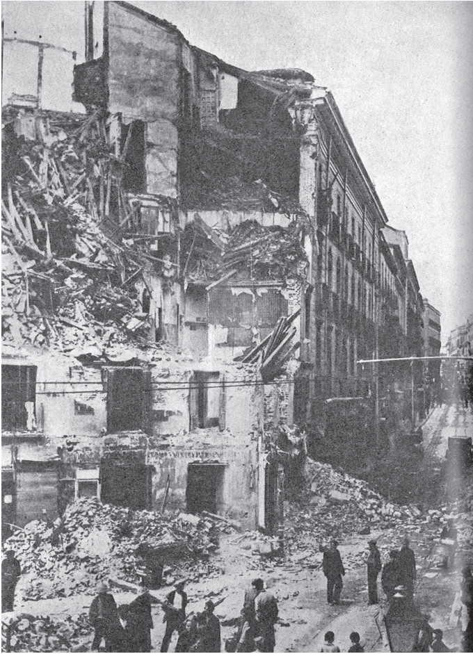
Kuva 3. Raunioitunut talo. ”Tällä hetkellä valmistautuu koko maailma tulevaan sotaan. Minkälaiseksi se muodostuu, siitä antaa käsityksen uusi sodankäyntiteoria edotto masta hävityssodasta .” Näin kirjoitettiin vuonna 1937 Akateemisen ilmansuojeluyhdistyksen julkaisemassa kirjassa Ilmapuolustus sanoin ja kuvin . Siinä julkaistiin neljä kuvaa Madridin ilmapommitusten tuhoista. Raunioituneen talon kuvan alla luki: ”Pommituksien tarkoitus on hävittäminen, häiritseminen ja vastustajan moraalin heikentäminen.” Kuva Ilmapuolustus sanoin ja kuvin . toim. Kalervo Elomaa. SKS:n kirjapaino 1937, 13, 82.
